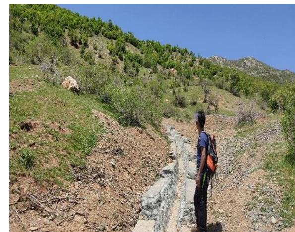
شکل ۱: زهکشی آب های سطحی منطقه با احداث کانال های بتنی
