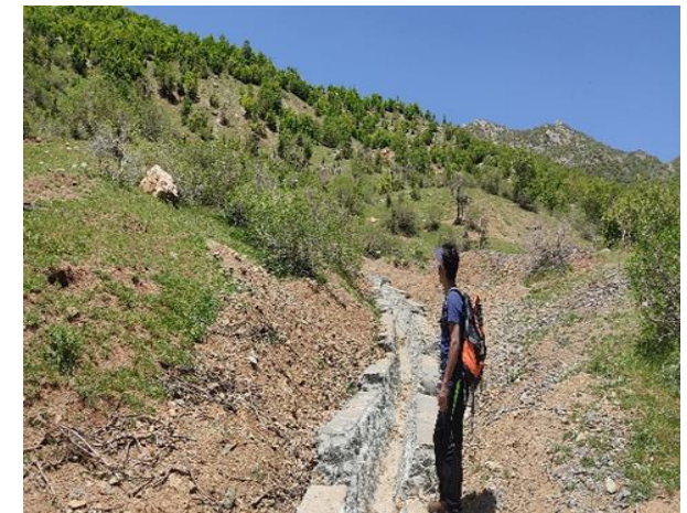
شکل ۱: زهکشی آب های سطحی منطقه با احداث کانال های بتنی
